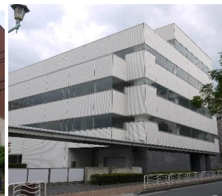
東陽町オフィスビル
