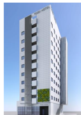
NEW: ホテル（建設中）
