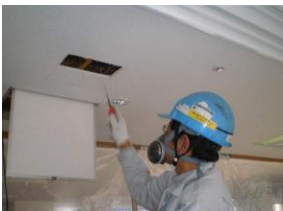
設備改修（アスベスト処理）
