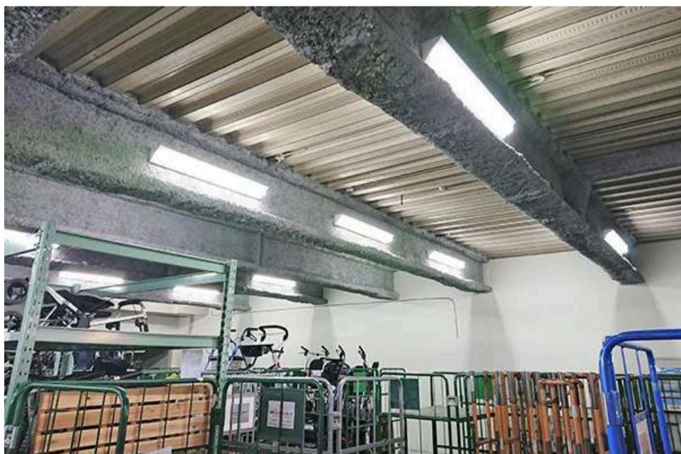
全館LED工事の推進
