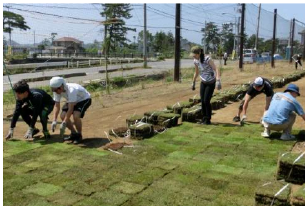
グラウンド整備
