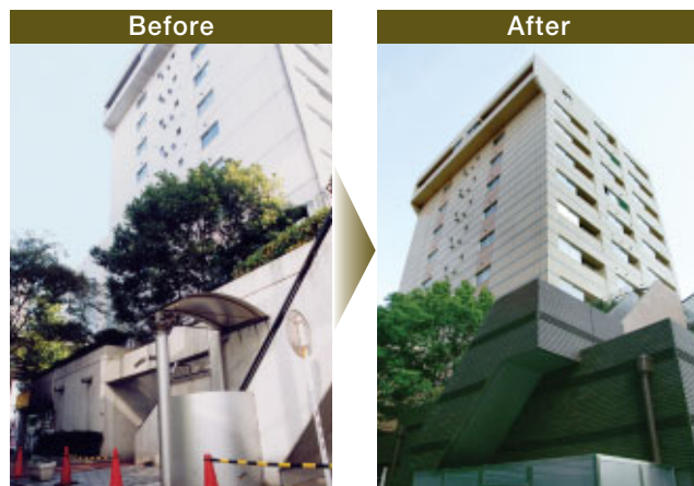
1981年竣工の物件で、外壁、エントランス、外構計画を含めた共用部分を完全にリニューアルすることで新築同様に再生した「パームス五反田」(品川区)
