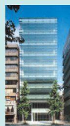
虎ノ門トーセイビル外観
