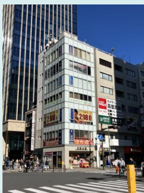
千代田区 商業ビル
