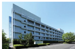
板橋区 収益ビル
