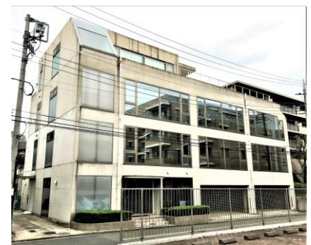
横浜市 空ビル
